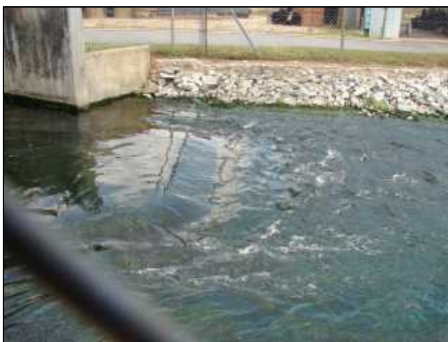
Figure 5. Station d'épuration de Beetham à Trinité.
