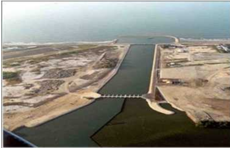
Figure 6. Embouchure stabilisée de marée.
