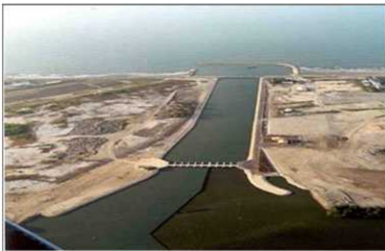
Figura 6. Bocana Estabilizada de Marea
